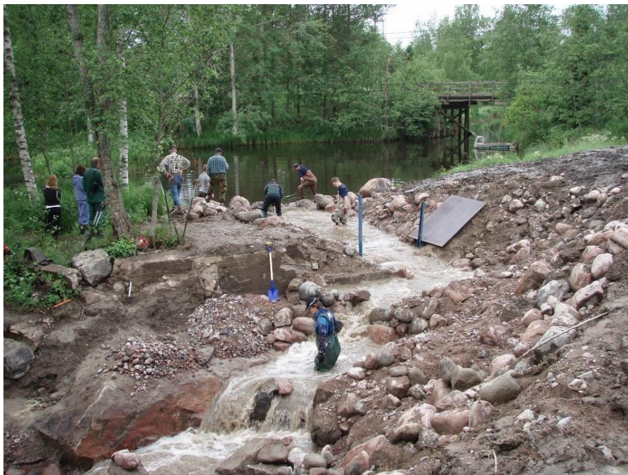
kuva 18. Kalatien rakennustalkoot
