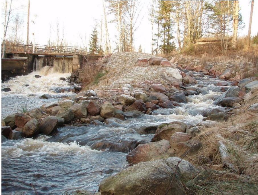
kuva 17. Virhon rakentama padon ohitusuoma
